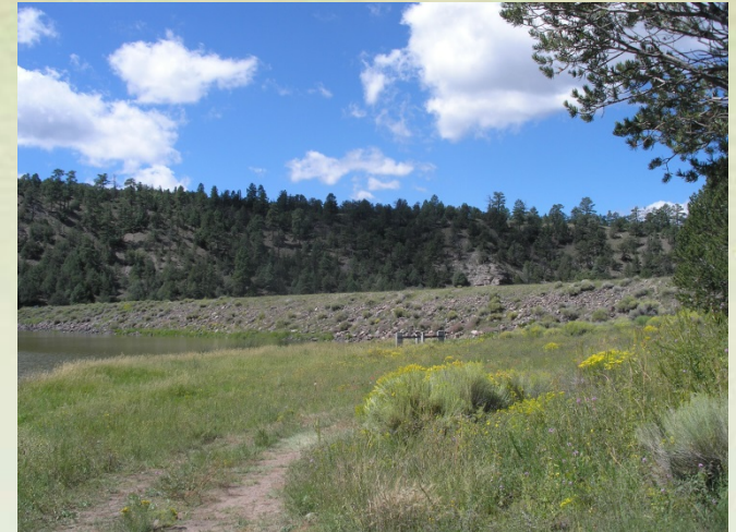
Quemado Lake Dam
